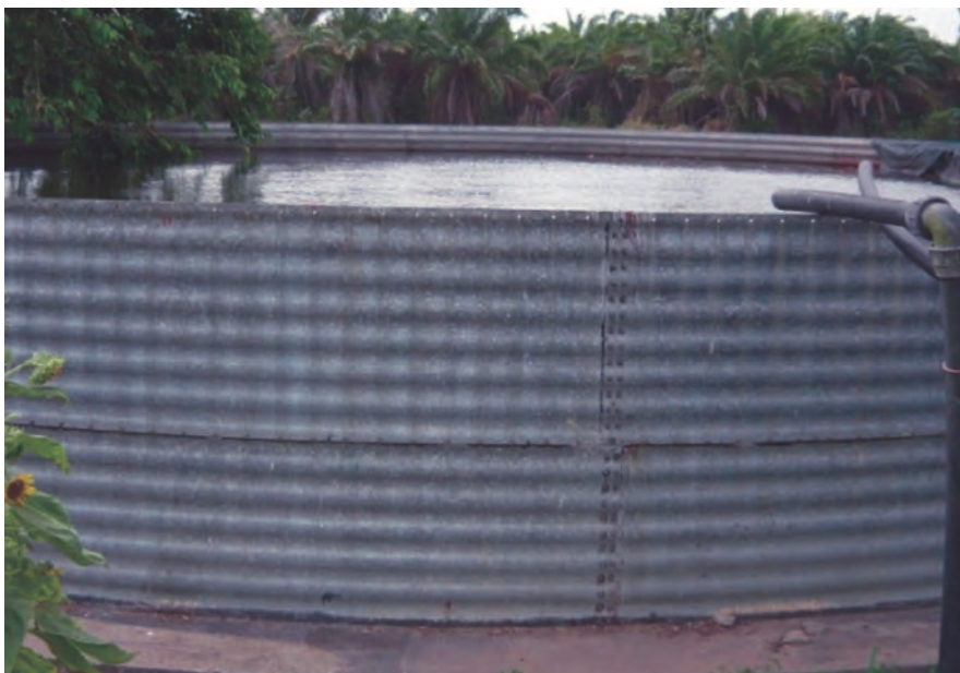
Foto 2. Tanque australiano 250.000 litros de agua.
