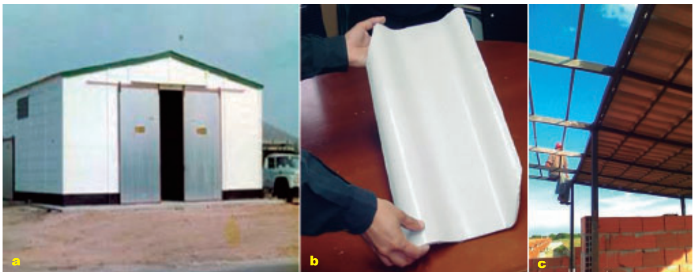
Foto 1 a, b y c. Fachada modelo del galpón, teja y techo de teja ecológica de micro concreto.
