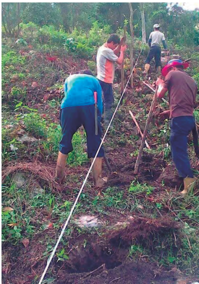
Foto 19. Para el trazado se utilizaron cabuya y estacas.
