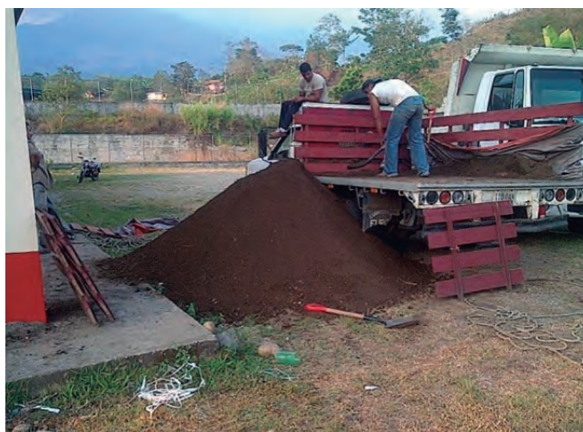
Foto 12. Descarga de tierra negra.
