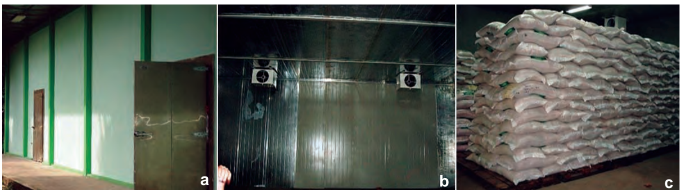
Foto 3. Cava de almacenamiento de semillas. a) Fachada de entrada, b) Acondicionamiento interno de la cava y c) Lote de semilla de arroz almacenado.
