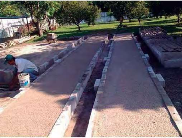
Foto 6. Nivelación de arena.
