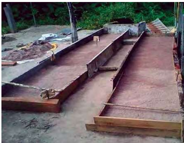
Foto 2. Construcción de germinador.
