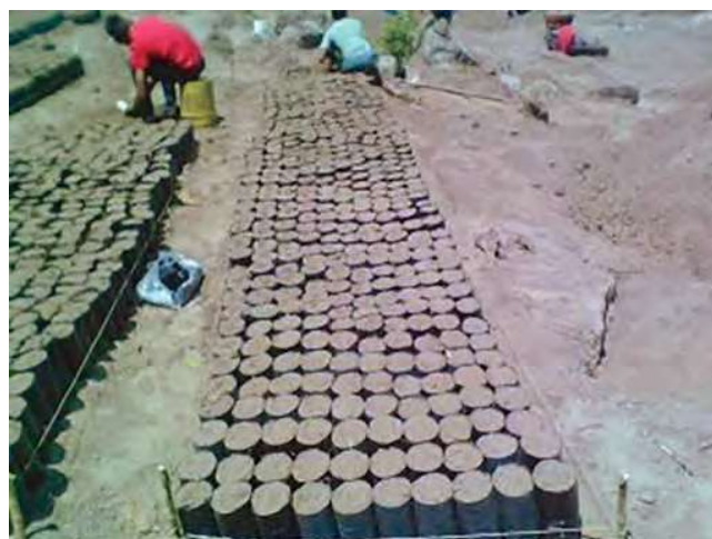
Foto 14. Trazado y encarrado de bolsas.
