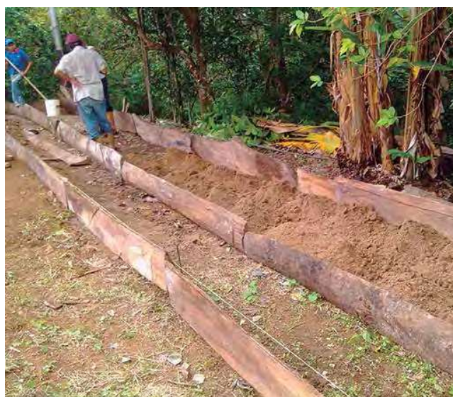
Foto 4. Llenado de canteros con arena lavada de río.
