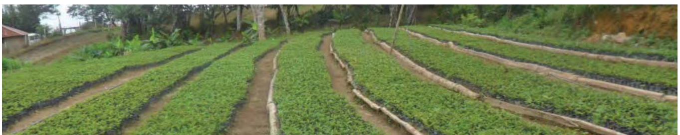
Se realizó el acondicionamiento del terreno para vivero en pendiente.
