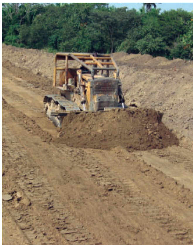
Foto 3. Construyendo laguna de piscicultura.
