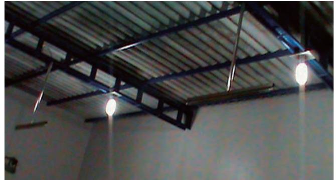
**Foto 6.** Lámparas de aplicación de radiaciones Ultravioletas.
