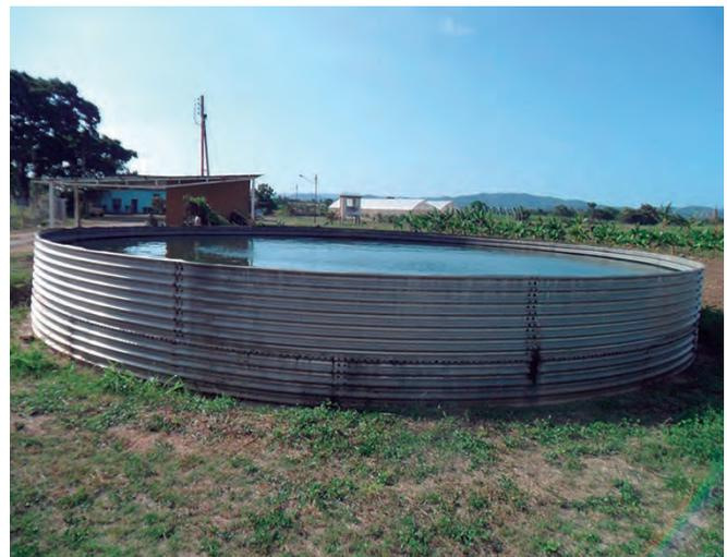
**Foto 1.** Tanque australiano de 200m<sup>3</sup> utilizado para el cultivo.
