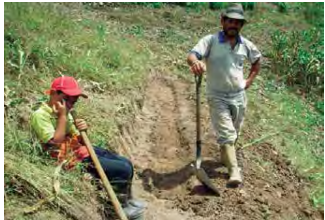
Foto 31. Construcción de la acequia con herramientas manuales.
