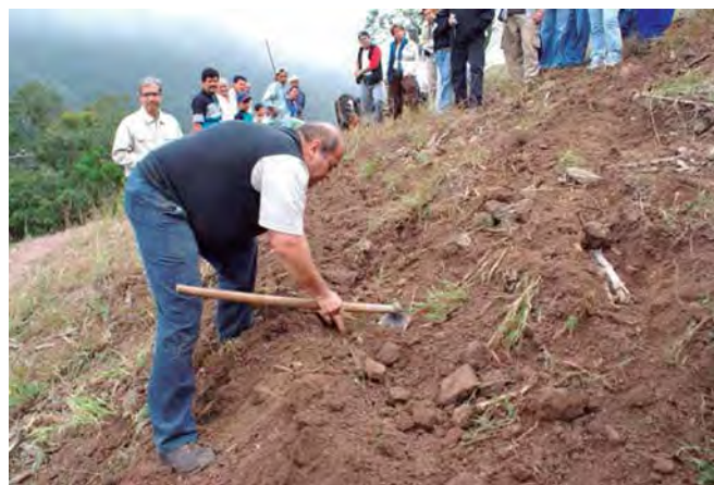
Foto 27. Construcción de zanjas iniciada con el arado metálico.
