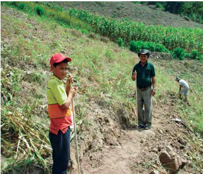
Foto 30. Inicio de la construcción de una acequia de ladera por tres generaciones de una familia.
