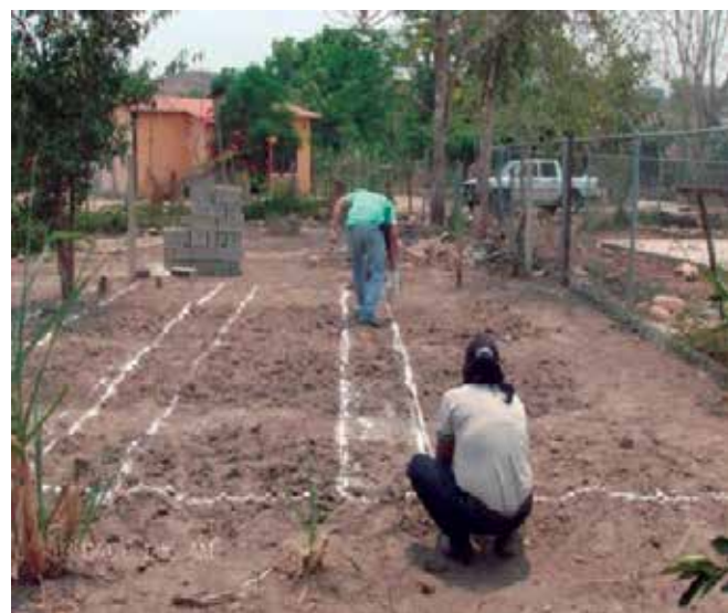
Foto 2. Demarcación del terreno.
