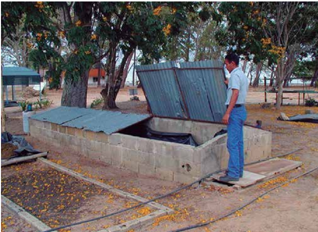
Foto 2. Cama doble permanente, construida con bloques y cubierta de láminas de zinc.
