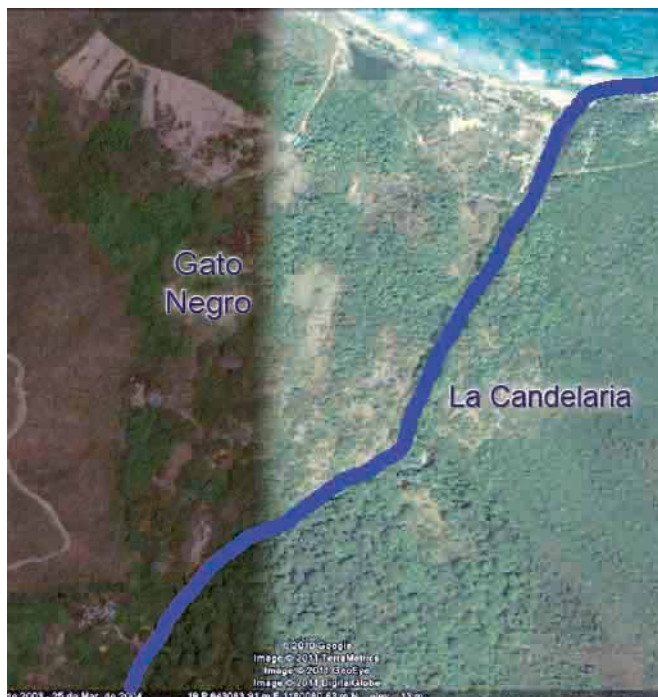
Foto 1. Imagen satelital, que muestras los sectores “Gato Negro”, lado oeste del río y “La Candelaria”, lado este. Fuente: Google Earth de fecha 24/01/2010.
